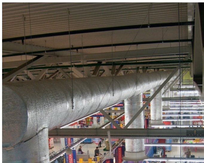
▲ Рис. 3. Пространство под перекрытием в торговом зале
