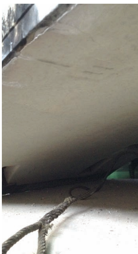
▲ Рис. 13. Вид обогреваемой поверхности после окончания испытаний
