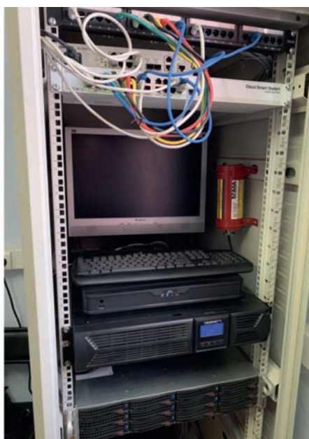
▲ Рис. 3 Примеры защиты шкафов в электрощитовой и в серверной
