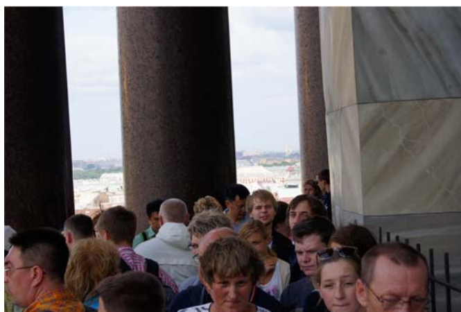
Рис. 1. Иллюстрация к посещаемости колоннады Исаакиевского собора, не имеющей нормативных путей эвакуации
